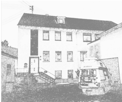
Foto Bestand Wohnhaus und Scheune
