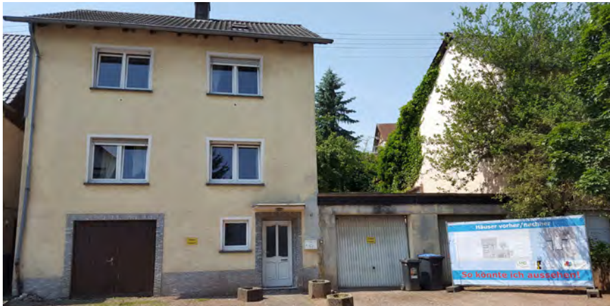
Bahnhofstrasse in Wustweiler mit Plakat zur Neugestaltung des Wohnhauses
